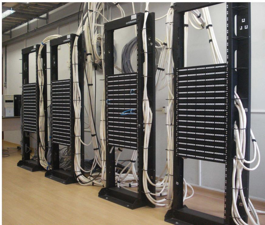
Figura 1: Visão frontal do conjunto de *racks* com *voice panels*.
