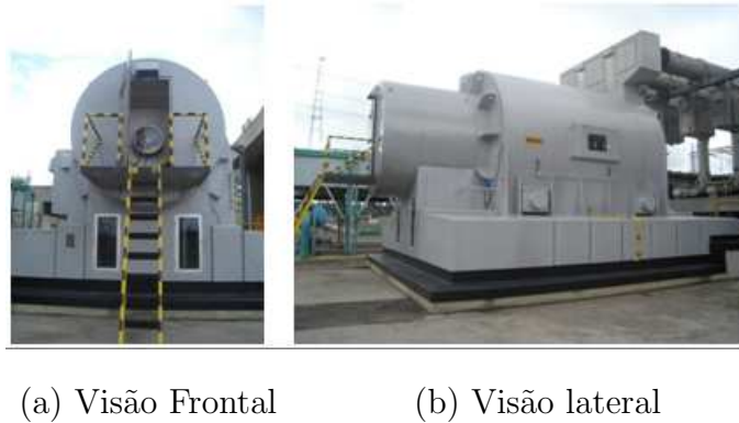
Figura 3.1: Compensador Síncrono
