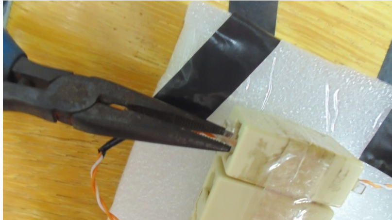
Figura 15. Alicates boca de jacaré, retirando o cabo
